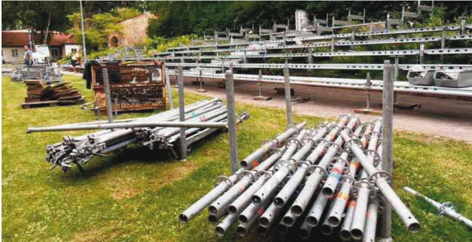
In elf Tagen beginnt die historische Wallenstein-Woche. Hinter den Kulissen laufen die Vorbereitungsarbeiten auf Hochtouren. Und auch das Stadtbild verändert sich zusehends: Im Reichshain (unser Foto) werden bereits die Tribünen für die Reiterspiele aufgebaut. Fotos: Olaf Schultze, Manfred Jörg
